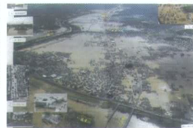
(※被災時の真備町の様子)
