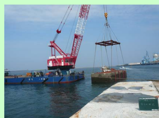
ケーソン撤去
