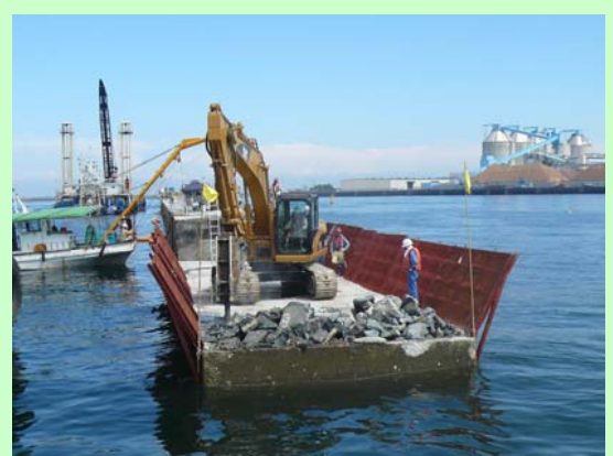
蓋コンクリート撤去
