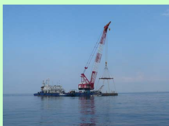
ケーソン据付
