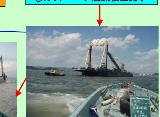
③浚渫土運搬状況(瀨取箇所～土運船)
